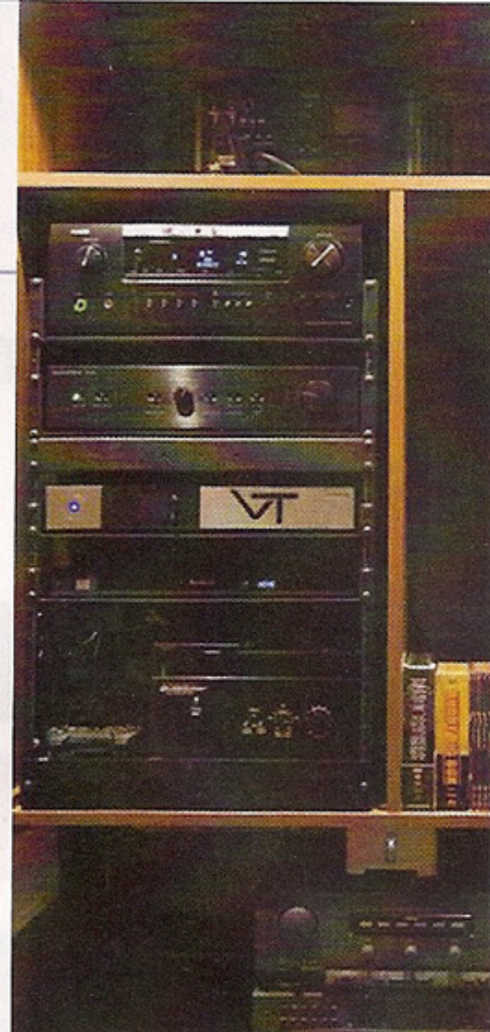
Die Hardware: Vom Vorraum aus hat man Zugriff auf alle Geräte.
